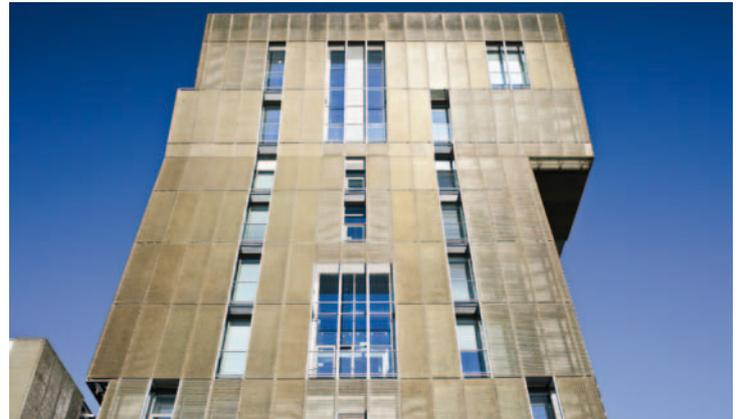
Fassadenverkleidung aus transparenten GFK-Gitterrosten.
