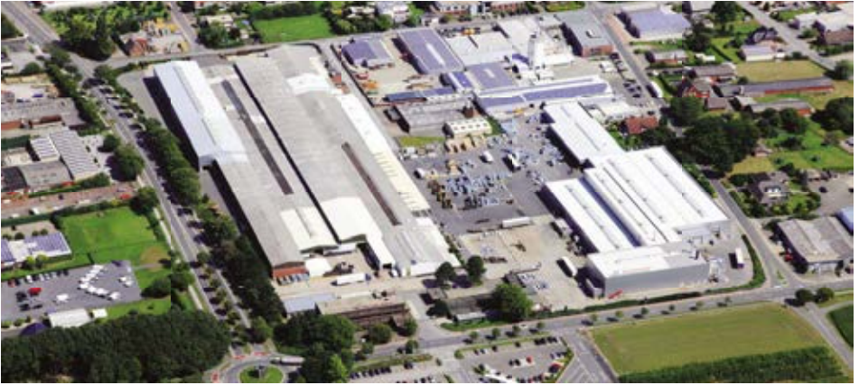
Lichtgitter - Stammwerk Stadtlohn
